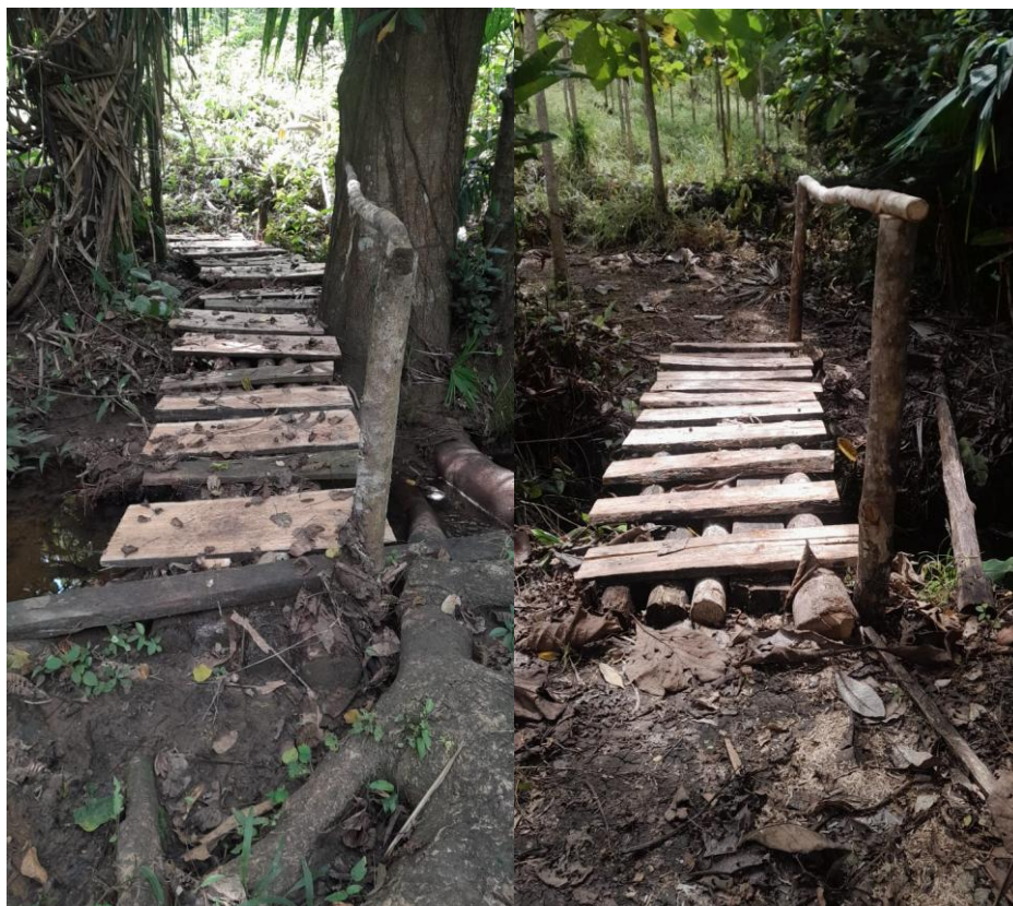
Figura 9. Se observa el mantenimiento de puentes del camino de la plantación.
